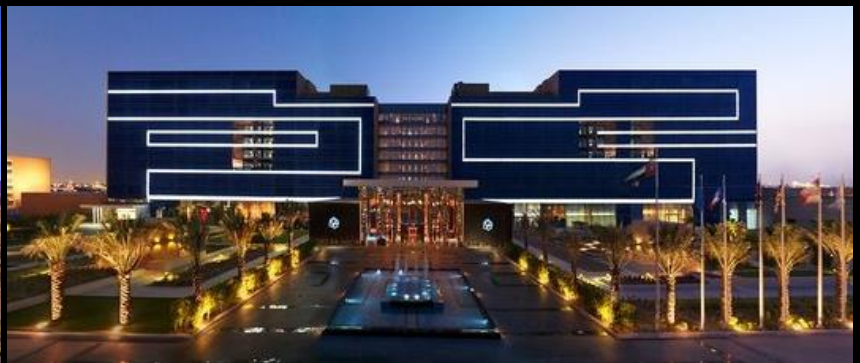
Shaza Doha, Katar
