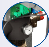
Zawór bezpieczeństwa, termomanometr
