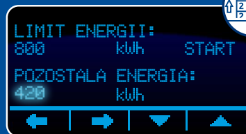
Licznik pracy kotła
