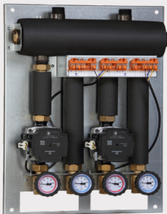
SZWADRON 070 (SKE 2DC+ 35 kW, 2 x UNI, pompy DN15) kod towaru 08 35 070
